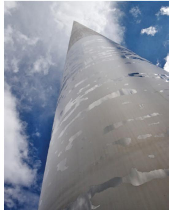
Le Dublin Spire - un exemple frappant de notre technique de texturation de surface montrant la polyvalence de grenailage contrôlé
